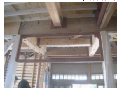
写真3 欄間構造補強施工
