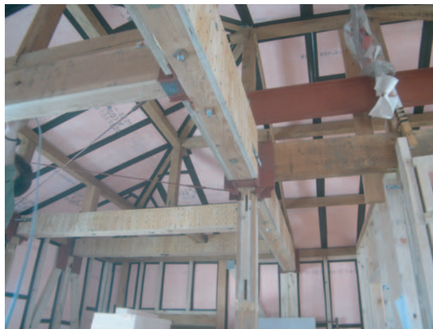
写真4 断熱補強施工
