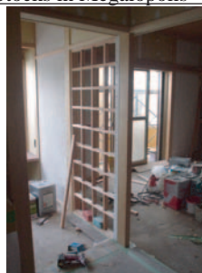
写真2 木格子構造補強施工
