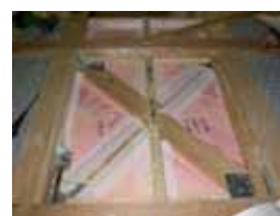
写真9 断熱改修実験改修試験体
