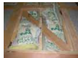
写真8 断熱改修実験既存試験体
