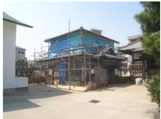
写真1 既存建築外観
