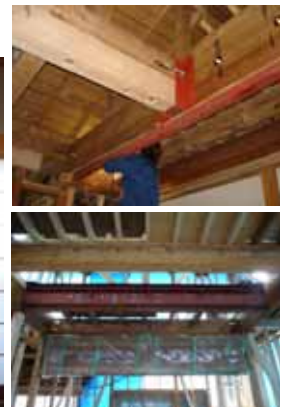
写真3・4 構造補強施工状況
