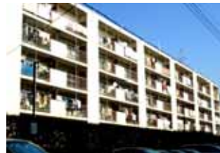
図6 既存の住棟の外観
