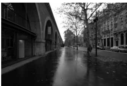
図-1 旧鉄道高架橋1 側面
