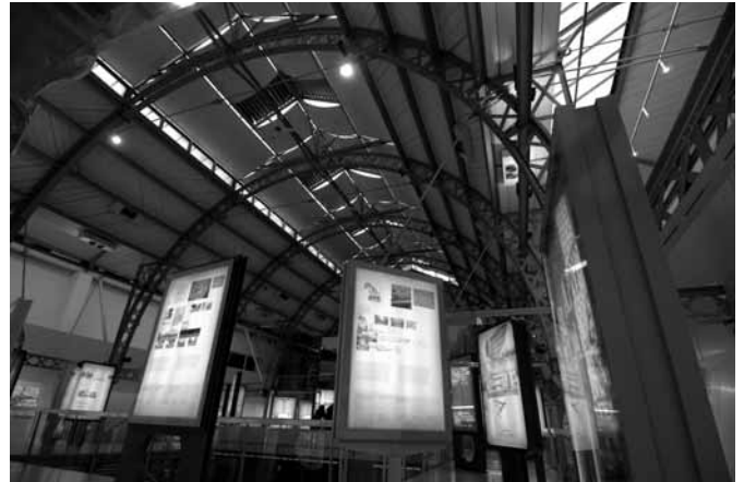
図-2 2階天井見上げ
