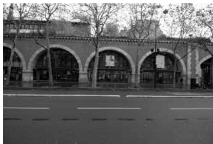
図-2 旧鉄道高架橋2 正面
