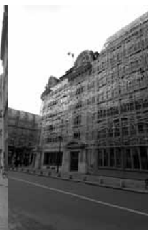
図-6 2棟の継ぎ目部分。
