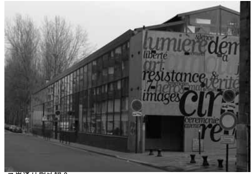
図-2 セーヌ岸通り側外観2
