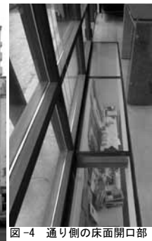
図-4 通り側の床面開口部
