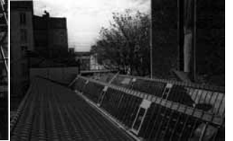
図-2 旧工場棟 鋸型屋根の開口部と屋根瓦。
